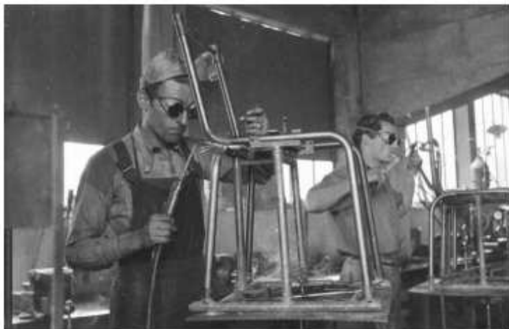
Soudure au chalumeau
