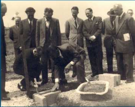
1957 : Pose de la première pierre des nouveaux abattoirs de Tully par Mr. Georges Pianta, maire de Thonon-les-Bains. "Les Tullierands"
